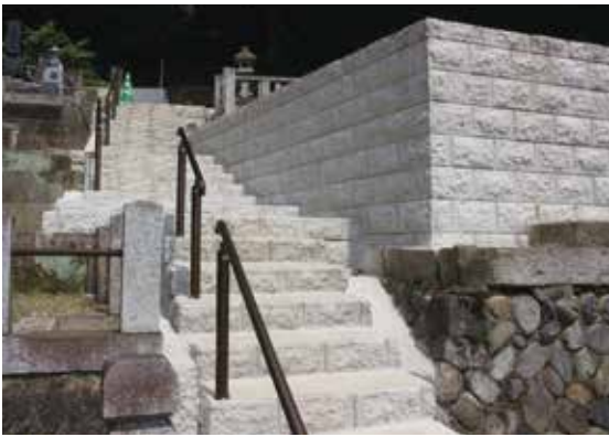
工事後の写真、同じ場所とは思えないほど変わりました
