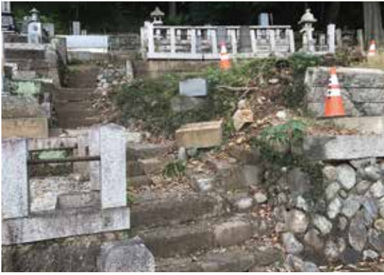
工事前の写真
